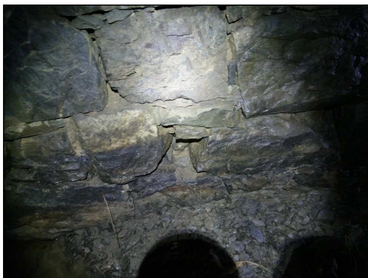
Obr. č. 10 – Opěra O 04 – vypadané kameny ve střední části
