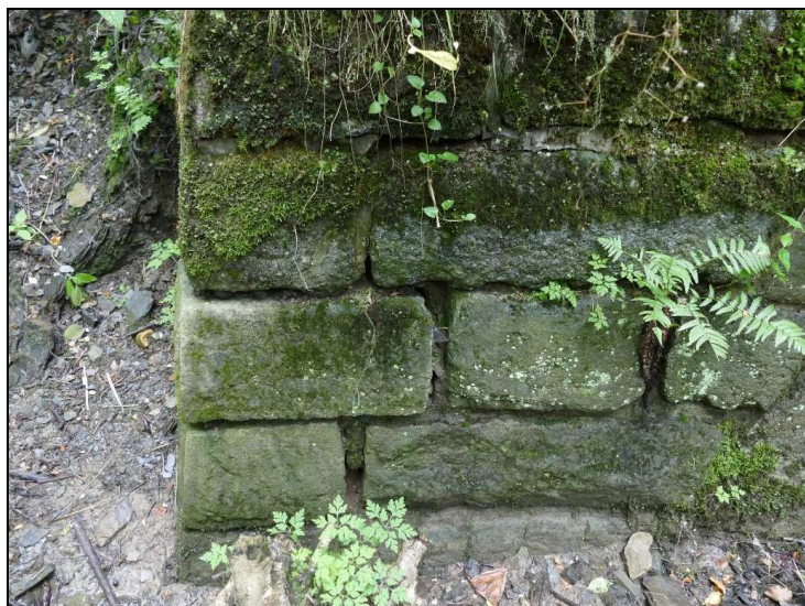
Obr. č. 7 – Opěra O 02 – křídlo vlevo – vypadané spárování
