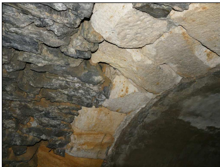
Obr. č. 4 – Konstrukce K 02 – vypadané kameny v levé části a zvětralé klenáky levého věnce
