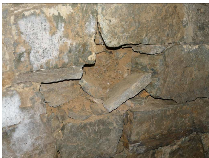
Obr. č. 8 – Opěra O 03 – vypadané kameny v levé části
