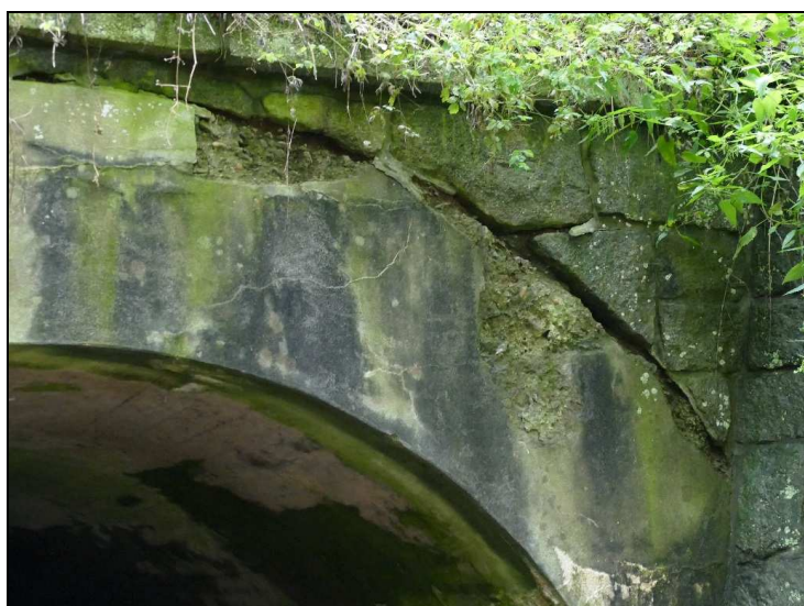
Obr. č. 2 – Konstrukce K 01 – degradace betonu vlevo z boční strany
