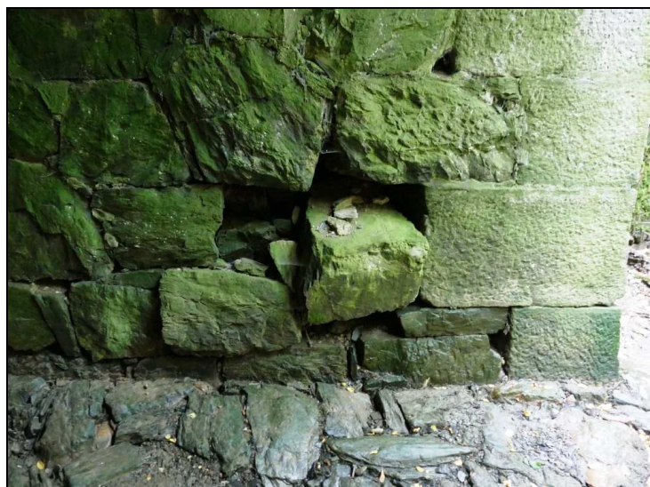
Obr. č. 11 – Opěra O 04 – vpravo vypadané kameny
