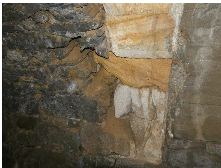
Obr. č. 3 – Konstrukce K 02 – vypadané kameny v levé části a zvětralé klenáky levého věnce
