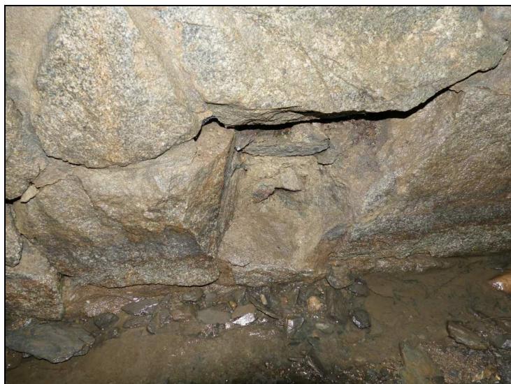
Obr. č. 5 – Opěra O 01 – vypadané kameny v dolní části
