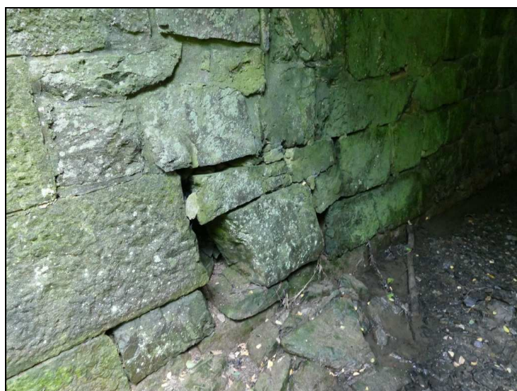
Obr. č. 9 – Opěra O 03 – vpravo vypadané kameny
