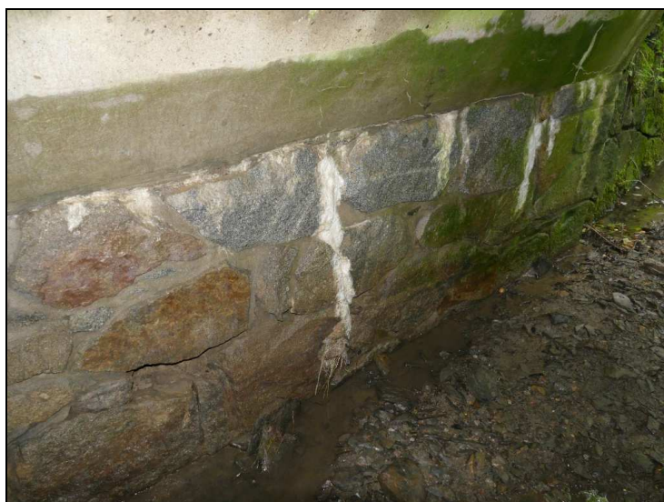
Obr. č. 1 – Konstrukce K 01 – průsaky vody s výluhy pojiva z úložné spáry
